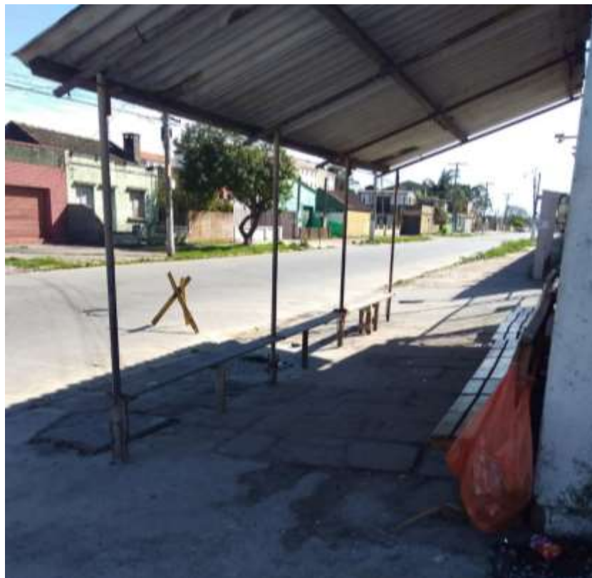
Figura 2: Visão do local coberto destinado a formação da fila dos/as visitantes
