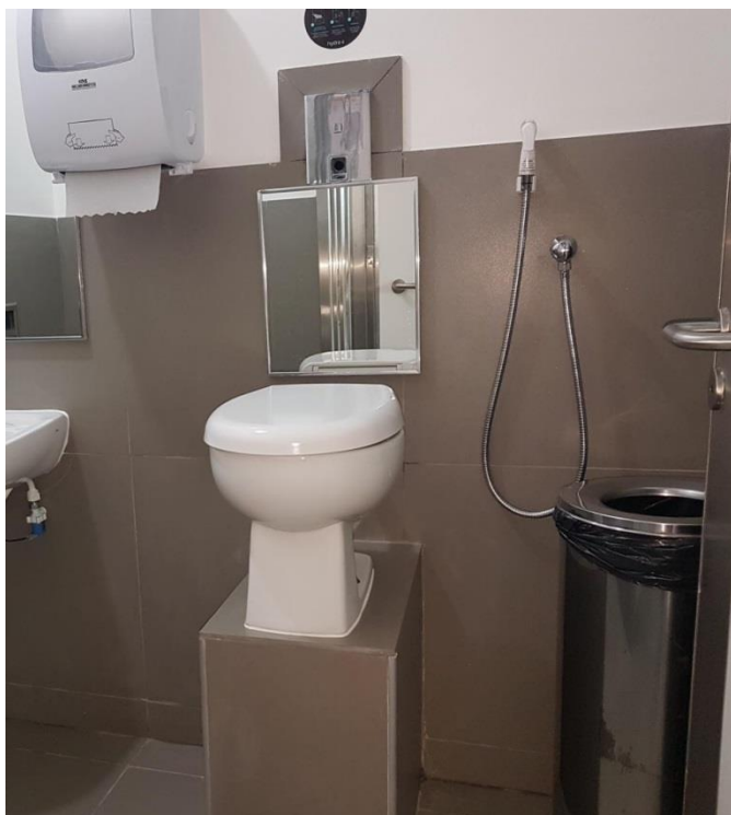
Figura 4: Banheiro público adaptado para pessoa com estomia
