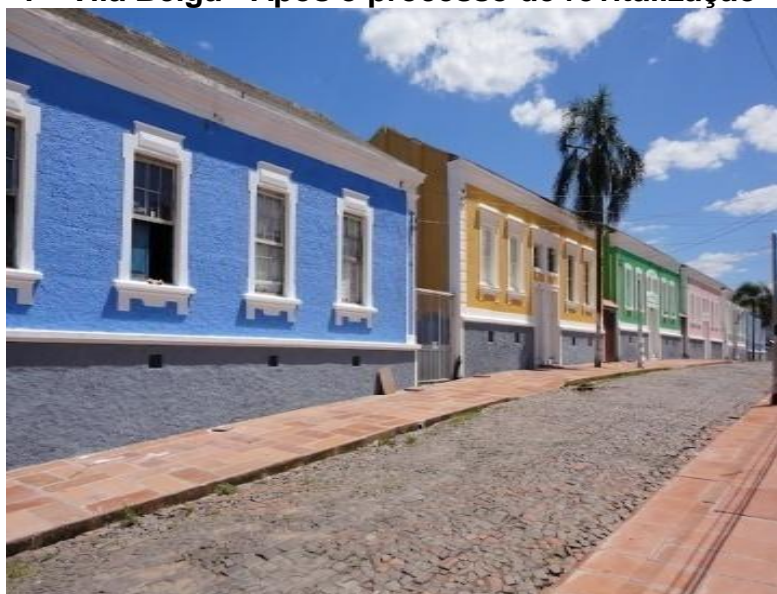
Foto 7 - Vila Belga - Após o processo de revitalização
