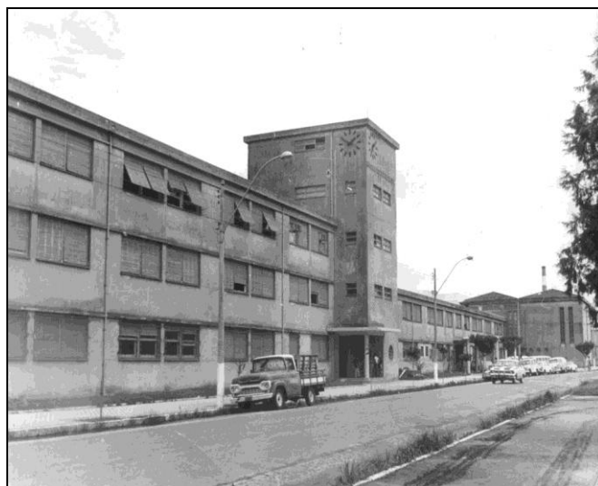
FIGURA 1 – Fachada frontal da Escola Técnica de Pelotas (1962), ainda sem o revestimento com pastilhas
